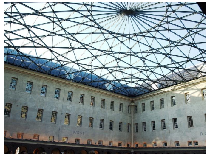
De glazen overkapping van de binnenplaats
